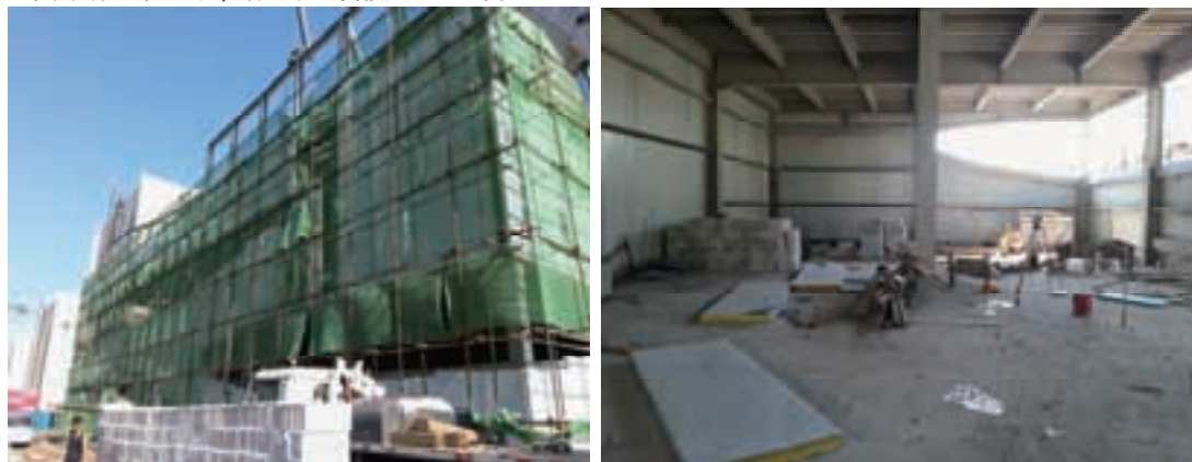
外墙板安装南立面
